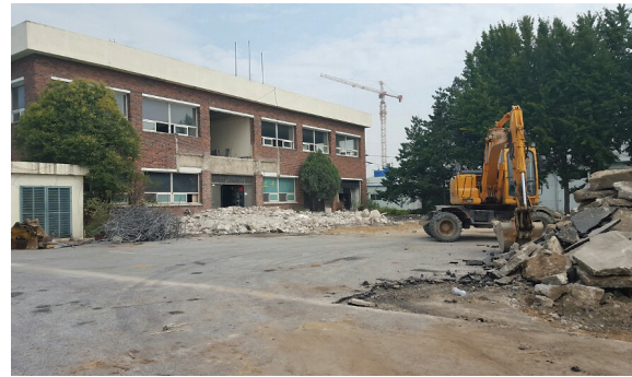
사업대상지 소촌농공단지 관리사무소 터파기 공사
