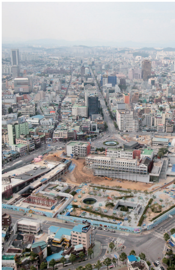
구 도청 앞 분수대와 국립아시아문화전당 공사 현장
